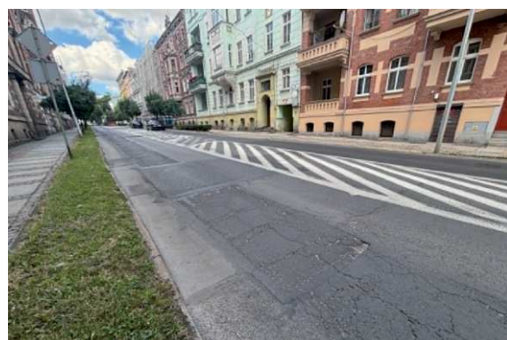
Przebudowa ul. Bolesława Chrobrego strona 5
